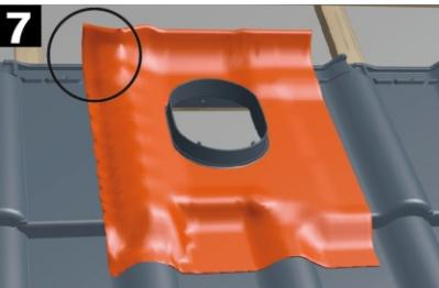
Horní část límce je nutno ohnout směrem nahoru. V případě použití střešních tašek je třeba nadbytečnou část límce uříznout tak, aby lícovała s horním zámkem tašky.
